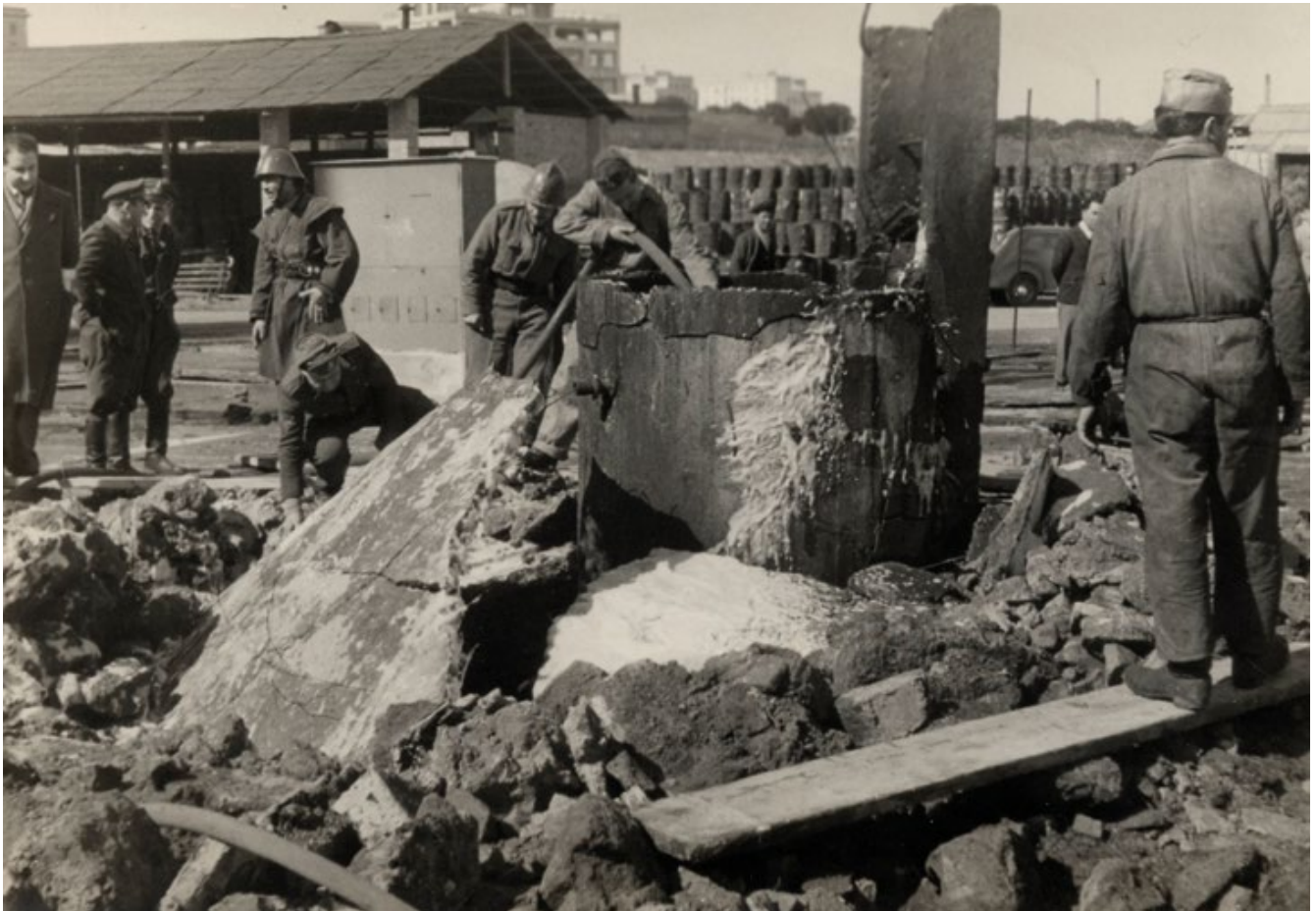
Crollo di un cantiere, 2 marzo 1950
