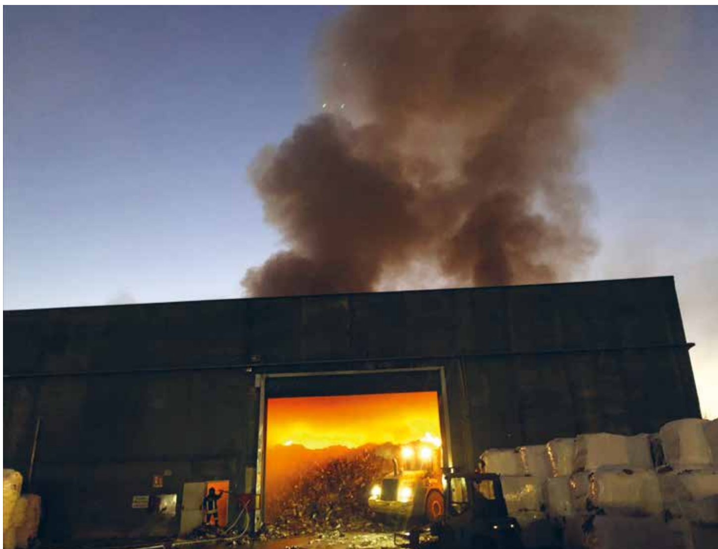
INCENDIO Sito Tritivagliatura ed Imballaggio Rifiuti S.MARIA C.V. ottobre 2019
