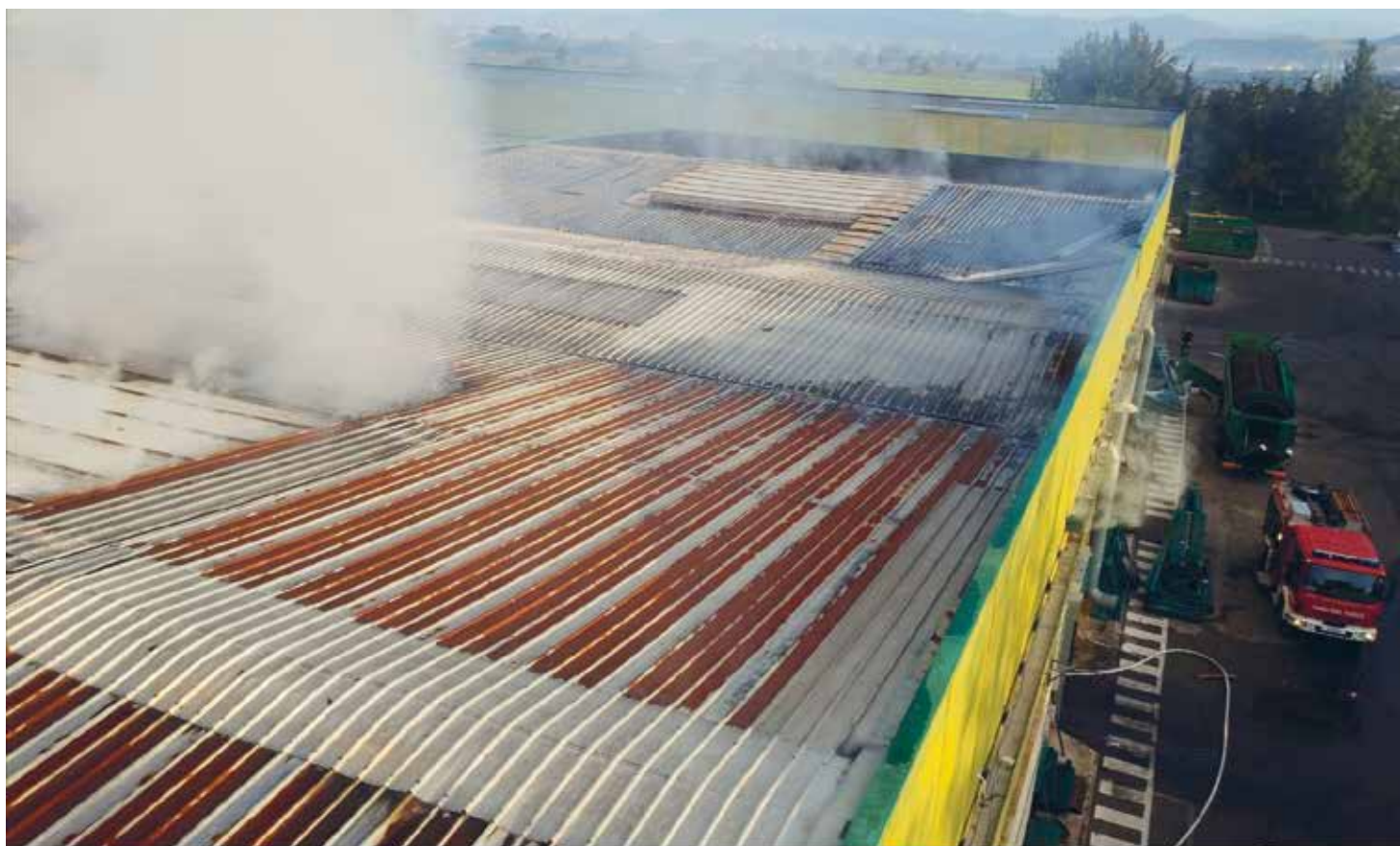
INCENDIO Sito Tritovagliatura ed Imballaggio Rifiuti (STIR) S.MARIA C.V. ottobre 2019
