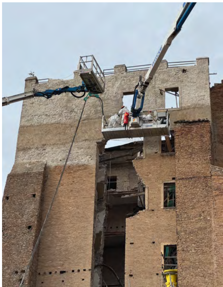
Vista finale con l'integrazione tra sistemi FRCM e puntellamenti in legnolacciaio
