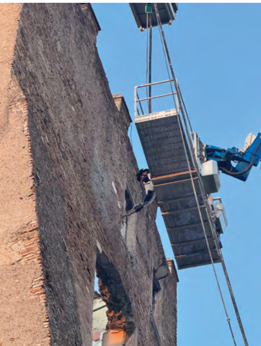
Operazione in quota con piattaforma aerea e stesa della rete
