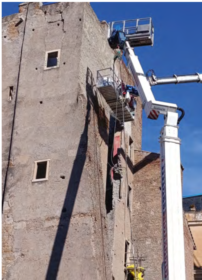
Operazione in quota con piattaforma aerea e stesa della rete
