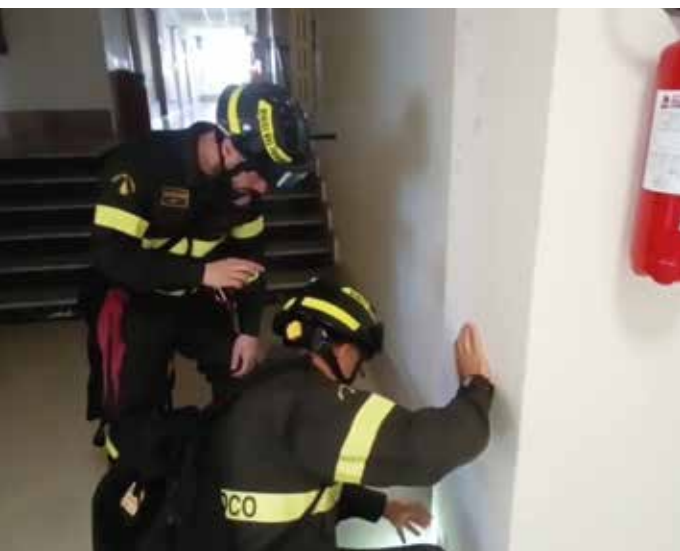
Figura 4 - Vigili del fuoco del Comando VF di Napoli intenti ad eseguire sopralluoghi per segnalato dissesto strutturale
