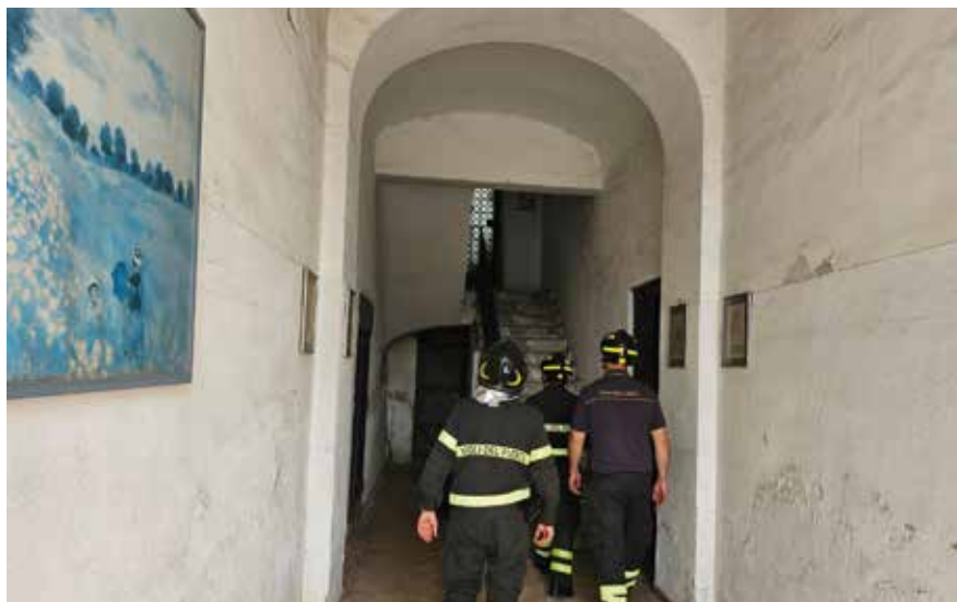
Figura 5 - Vigili del fuoco del Comando VF di Napoli intenti ad eseguire sopralluoghi per segnalato dissesto strutturale.
