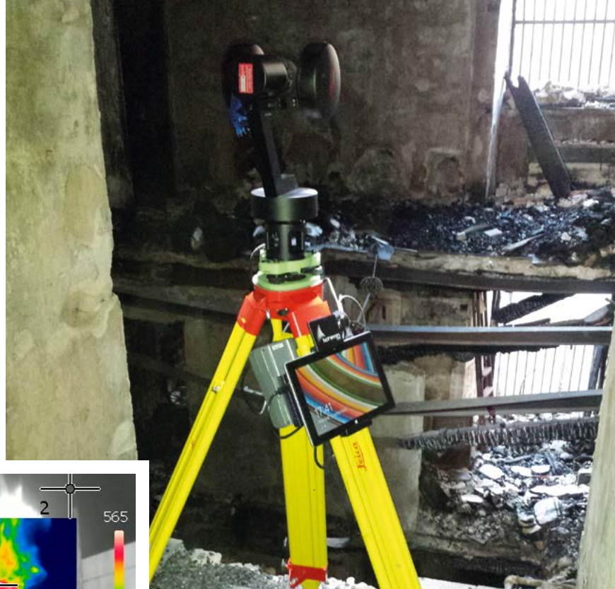
Le immagini riportano alcuni screenshot relativi alle fasi di esecuzione dei rilievi fotografici, geometrici nonché alla caratterizzazione dei segni d'incendio, oltre che ad una raccolta di reperti sullo scenario
