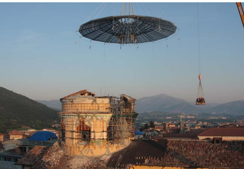
La spettacolare opera di posizionamento della copertura sulla chiesa delle Anime Sante
