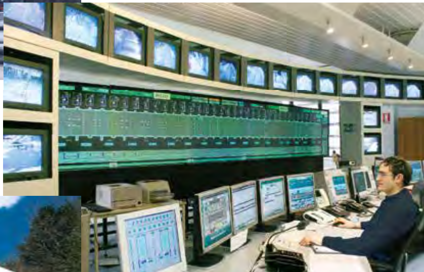
Sala comandi: strumenti di controllo del traffico e di monitoraggio delle condizioni ambientali interne del traforo
