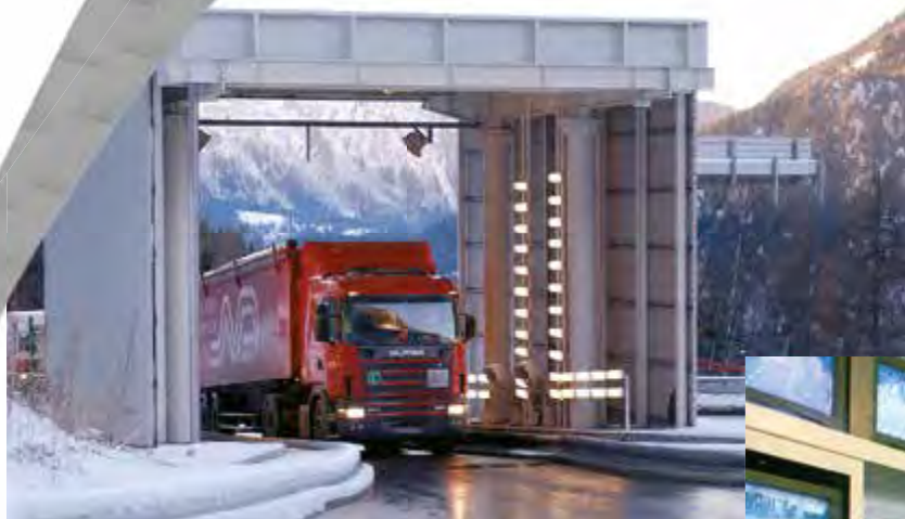
Portale termografico lato nord
