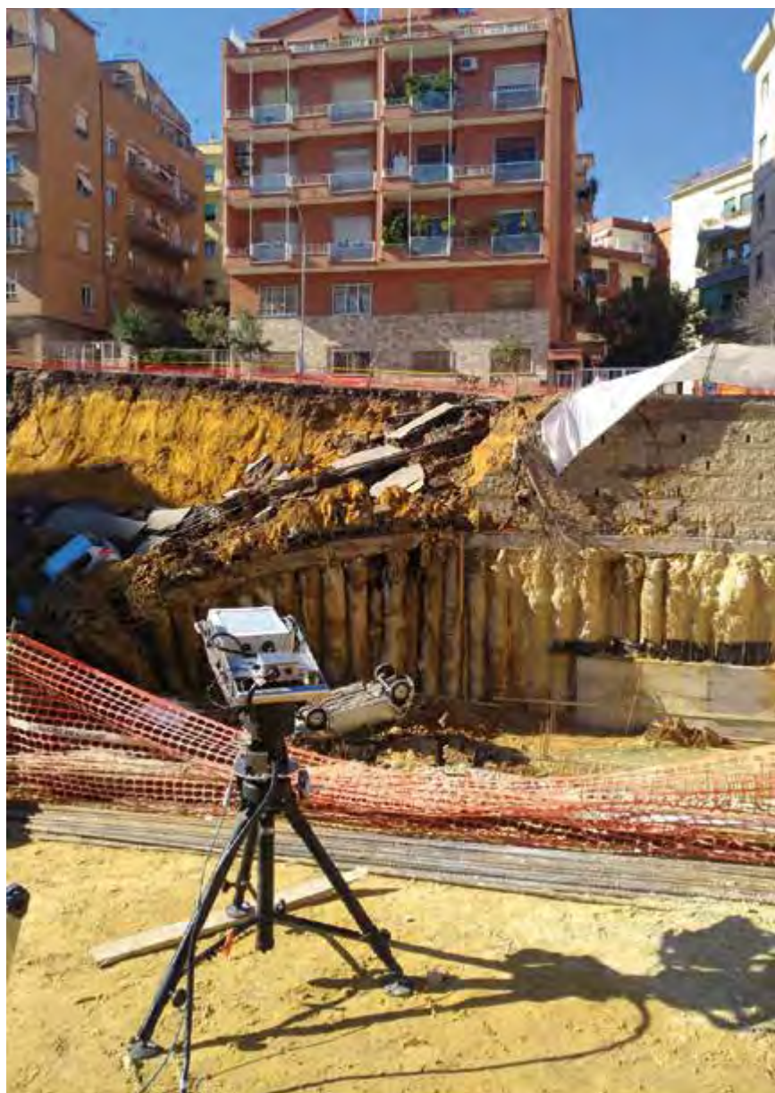
Crollo del tratto di via Livio Andronico in zona Balduina (Roma)
