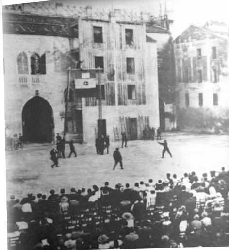
Civici Pompieri di Padova, montaggio di scale controventate in Prato della Valle. Inizio '900
