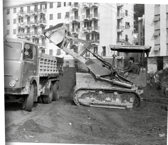
Alluvione di Genova, mezzi dei Vigili del Fuoco al lavoro per ripristinare le vie d'accesso alla città. 7 ottobre 1970
