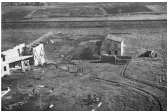
Roma - Il Centro di addestramento delle SCA 'Scuole Centrali Antincendio' negli anni 60
