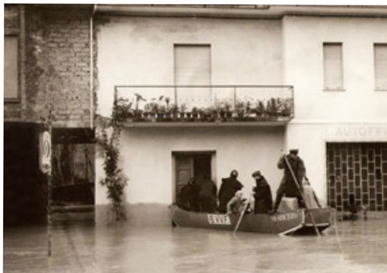
Arezzo - Distaccamento Volontario di Pratovecchio - Soccorsi nella alluvione del 1966 a Ponte a Poppi
