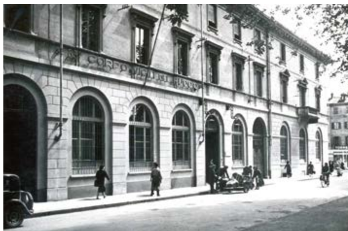
Torino - 83° Corpo VVF - Storica sede centrale di Porta Palazzo
