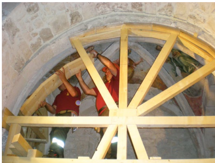
La posa di opere provvisorie su strutture lesionate dal sisma.
