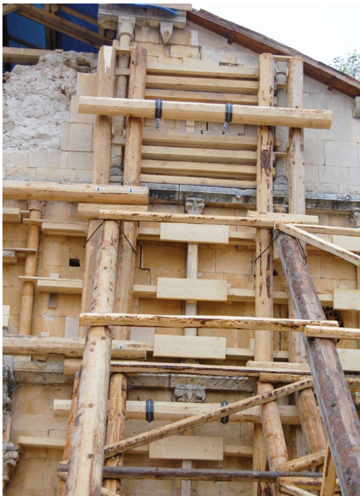
La posa di opere provvisorie su strutture lesionate dal sisma.
