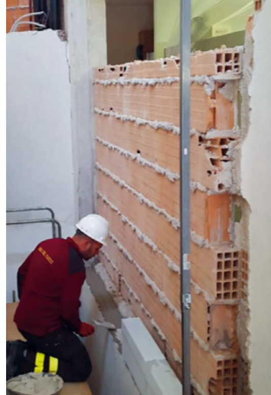
▲ Emergenza sismica centro Italia – Novembre 2016, ripristino murature di tamponatura interne Distaccamento VVF di Camerino
