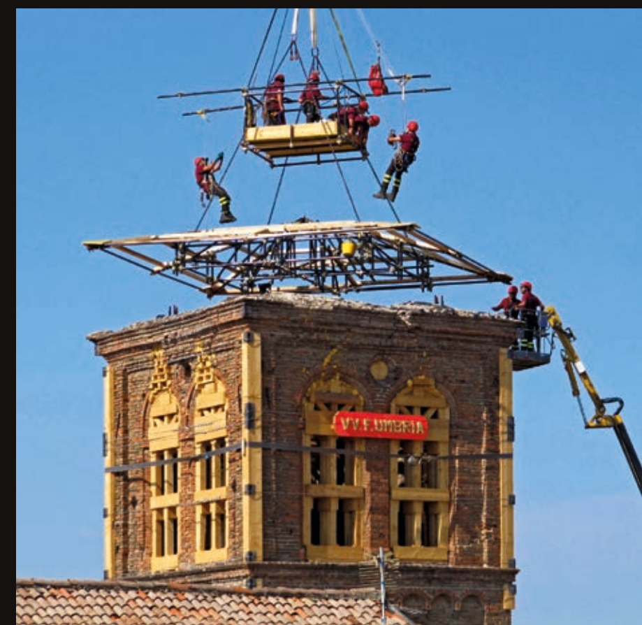
Sopra, specialisti SAF all'opera durante le operazioni per la messa in sicurezza dei beni architettonici dell'Aquila; sotto, Finale Emilia, posizionamento di una struttura metallica di contenimento.
