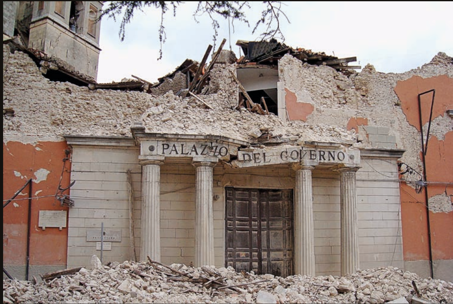
L'Aquila, il palazzo della prefettura distrutto dal terremoto.
