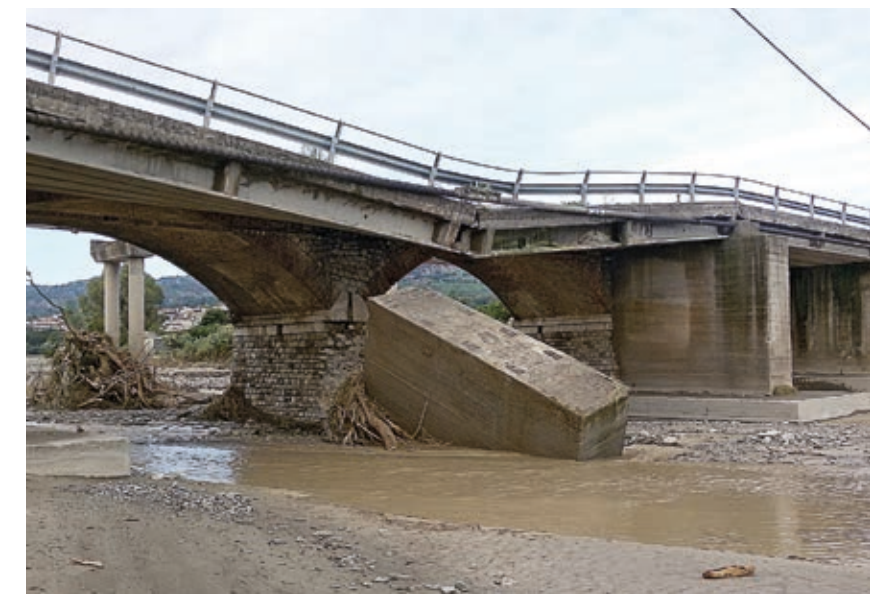
In alto, i drammatici effetti dell'esondazione delle fiumare nella zona della locride; in basso, crollo di un viadotto della SS 106 Jonica.
