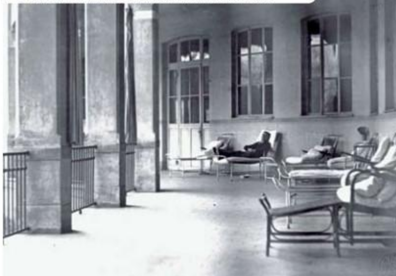
Padiglione Birago di Vische - ala sinistra, lato Dora; i loggiati per la terapia della "cura d'aria" per i tubercolotici, chiusi nella ristrutturazione del 2000
